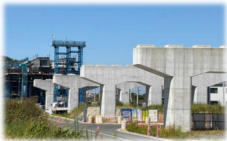
有明海沿岸道路（大島地区）
