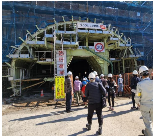
滝室坂トンネル
